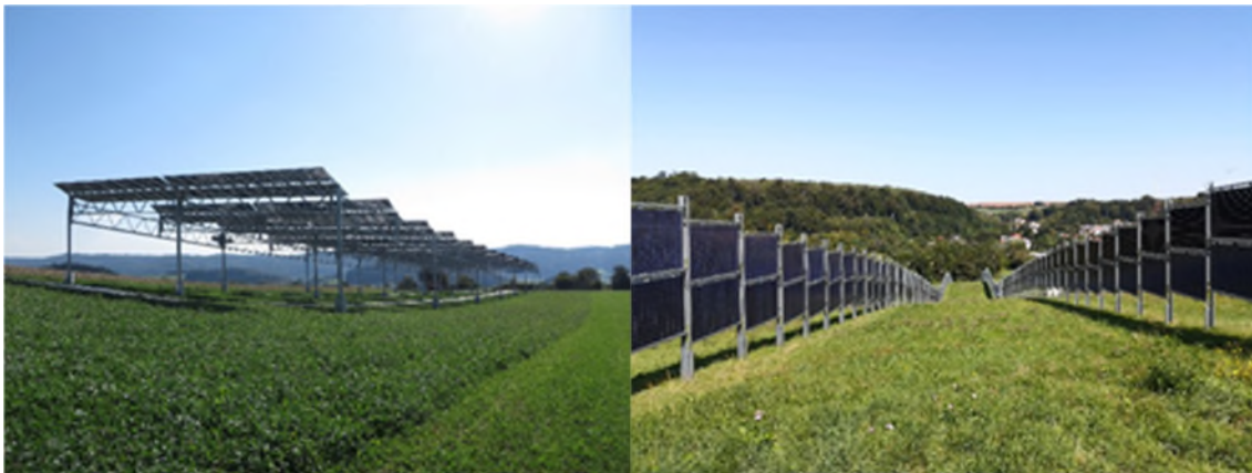
Abbildung 21: APV Konzepte (links: Horizontale Aufständerung - Forschungsanlage Heggelbach [39], rechts: vertikale Aufständerung - Anlage der Firma Next2Sun [40])
