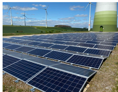
Abbildung 2: Formen von Wind-PV-Kraftwerken (li: APV-Pilotanlage in direkter Nähe zu Windenergieanlagen [3]; re: PV auf Kranstellfläche einer Windenergieanlage[4])
