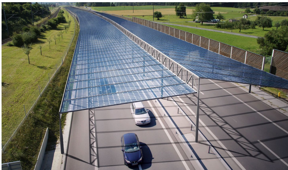
Abbildung 2: Visualisierung Überdachung mit integrierten PV-Modulen [3]
