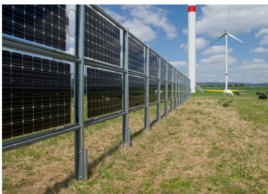
Abbildung 2: Formen von Wind-PV-Kraftwerken (li: APV-Pilotanlage in direkter Nähe zu Windenergieanlagen [3]; re: PV auf Kranstellfläche einer Windenergieanlage[4])
