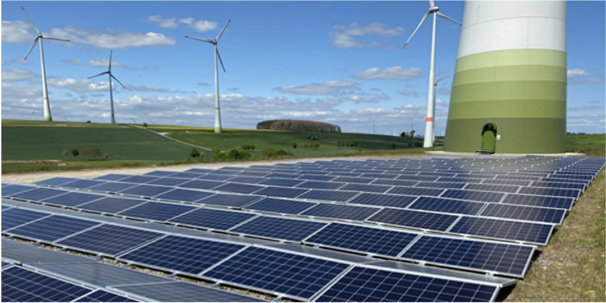
Abbildung 23: PV Anlage auf der Kranstellfläche einer Windenergieanlage der Firma Westfalenwind [41]
