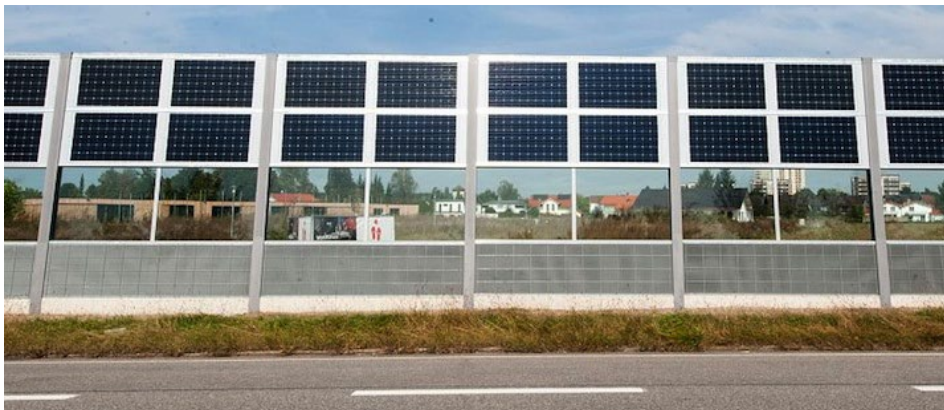
Abbildung 1: Lärmschutzwand mit integrierten bifazialen Photovoltaikmodulen in Neuötting [2]
