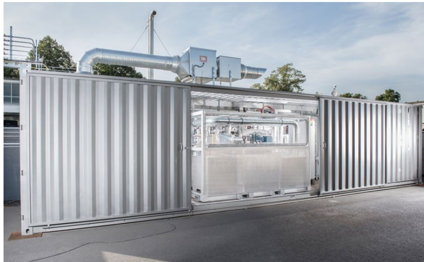
Abbildung 1: Beispiel für einen Elektrolyseur in einem Container-Modell [4]
